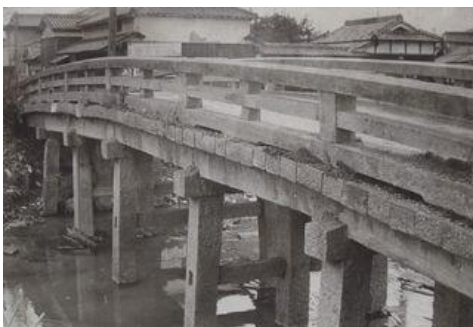
旧山陽道に掛かる天川橋
